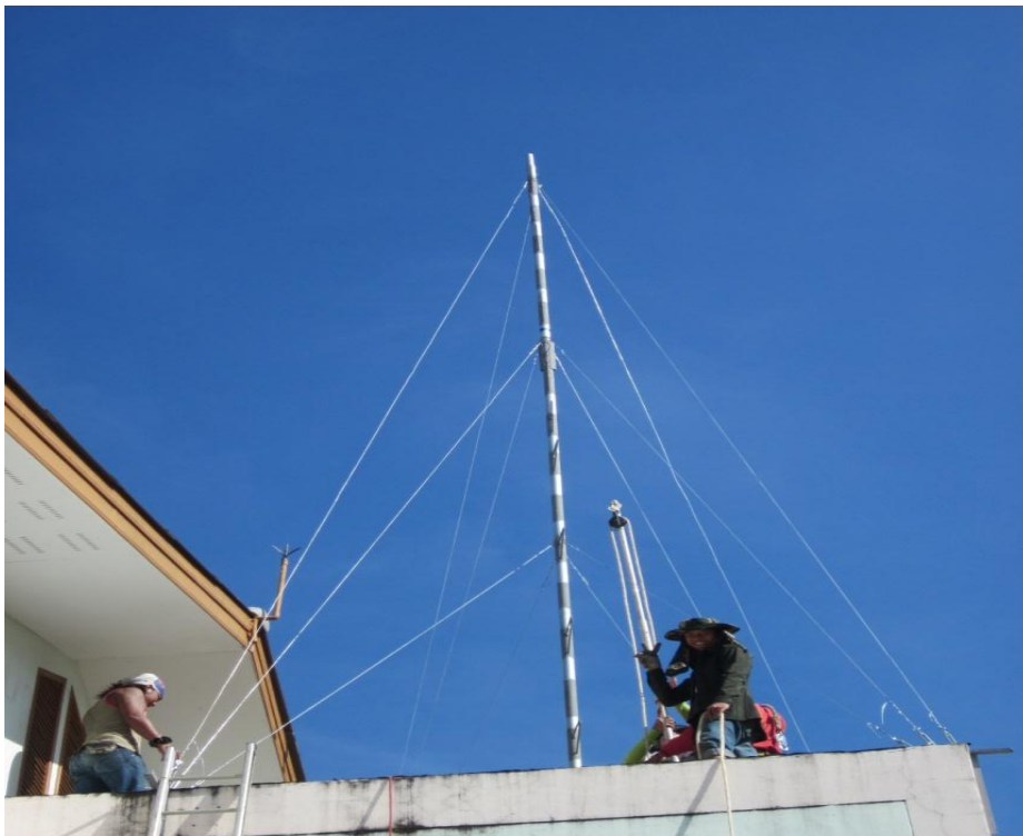
รูปที่ 6 การประกอบเสาสถานีสัญญาณวิทยุเพื่อใช้ในการติดตั้งแผงส่งสัญญาณวิทยุ ระบบ เอฟ
