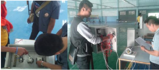
ภาพที่ ๔.๔ การประกอบตู้ควบคุม
