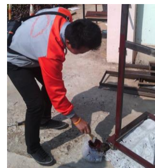
ภาพที่ ๔.๓ การทาสีเหล็กทำโครงสร้าง
