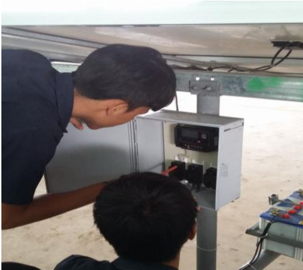
ภาพที่ ๙ การติดตั้งชุดควบคุม
