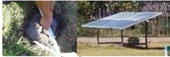
ภาพที่ ๙ การติดตั้งติดตั้งฐานรากและโครงสร้างแผงโซ ล่าเซลล์
