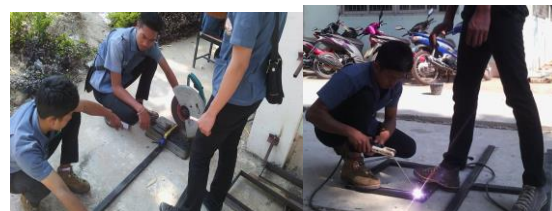
ภาพที่ ๔.๑ การตัดและเชื่อมเหล็กทำโครงสร้าง
