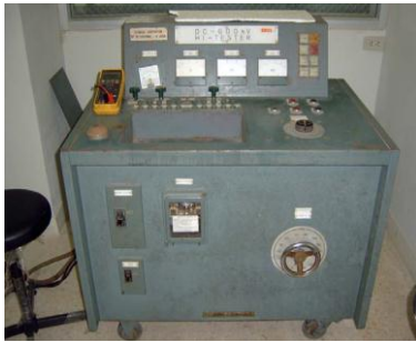
รูปที่ 7 ตู้ควบคุมการป้อนแรงดันให้กับ เครื่องกำเนิดแรงดันสูงกระแสตรงเมื่อ
