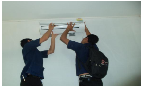
รูปที่ 3.7 การติดตั้งอุปกรณ์ต่างๆ
