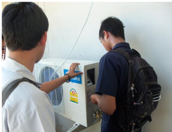
รูปที่ 2.9 ติดตั้งฐานวาง
