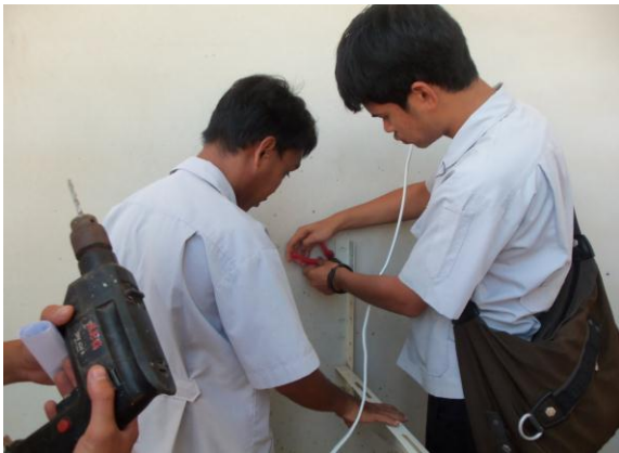
รูปที่ 3.8 เตรียมการติดตั้งคอยร์ร้อน ด้านนอก
