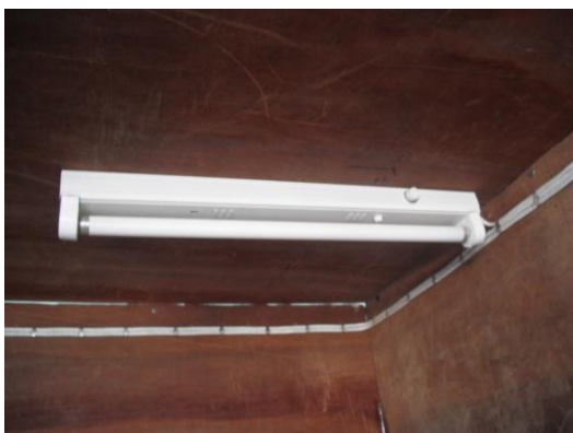
รูปที่ 4 การติดตั้งหลอดฟลูออเรสเซนต์
